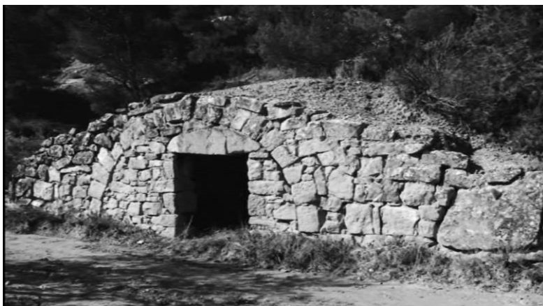
Construcció de pedra seca als camps de La Pobla.
